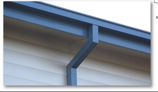
DMI GUTTER GUTTER OUTLET POP RIVET (EIGHT PER OUTLET) AND SEAL WITH NOVA LFEX OR EQUAL POP RIVET (4 PER DOWNSPOUT)
